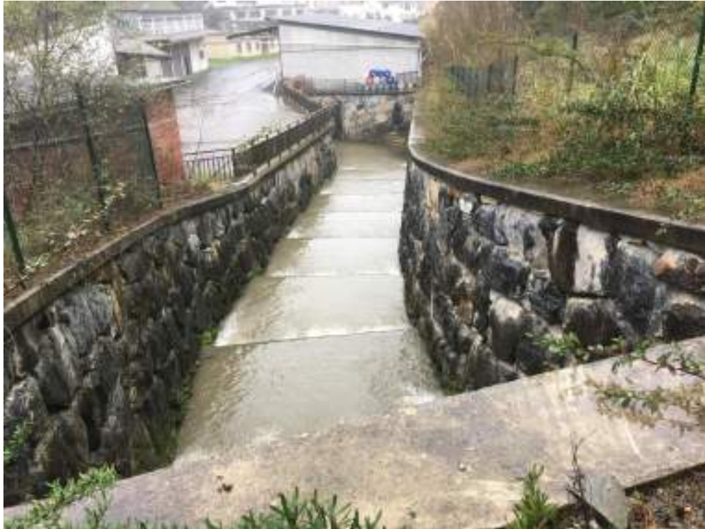
Fotografía N°1 Bajante escalonada, inicio del estudio.
